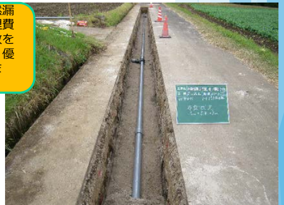
埋設管の布設替
