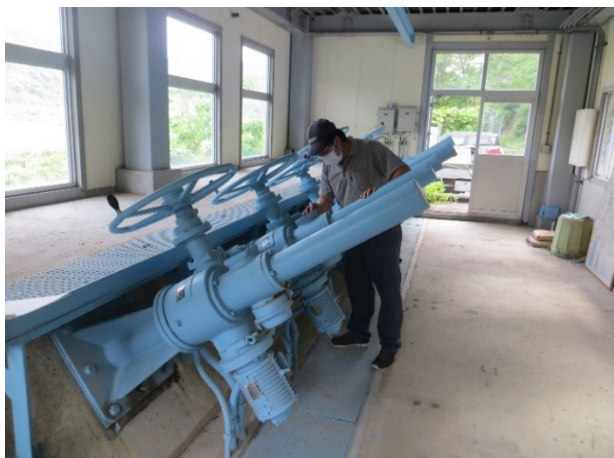
畑かん漏水対応（緊急止水、安全確保）
