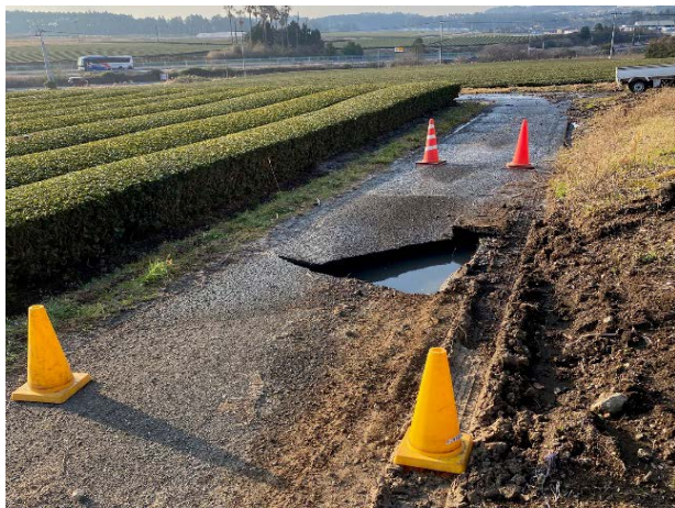
畑かん漏水対応（緊急止水、安全確保）
