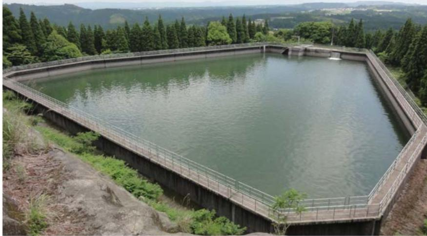
揚水機場からポンプアップされた河川水が一旦調整池へ貯留され、そこから自然流下で各台地へ送水されます。一定時間貯留されると河川水に含まれる泥などが沈殿します。また調整池には屋根がなく、台風などにより運ばれた杉枝などが入ってしまうので、数年間隔で清掃する必要があります。
